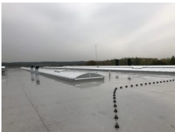
Skladová hala ASS / Warehouse
